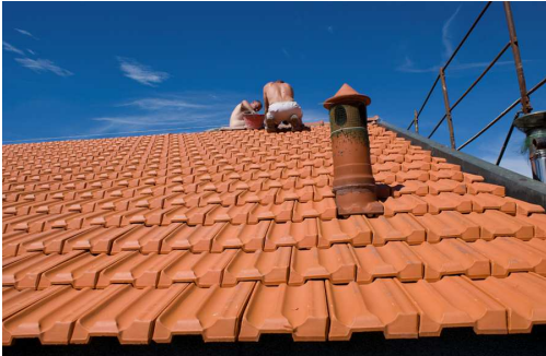
Rifacimento parte del tetto edificio Scuola dell'Infanzia
